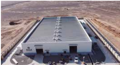
甘肃瓜州北大桥白杨风电配套储能项目
