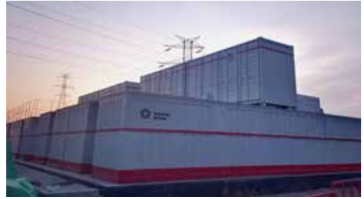
国家能源集团山东蓬莱电厂
